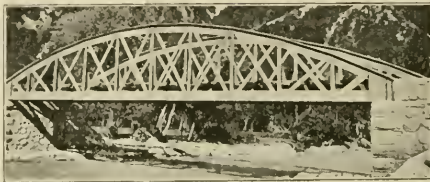
Abb. 146. Bogensehenträger, Fella-Brücke. [Taris-Pontafel.]
